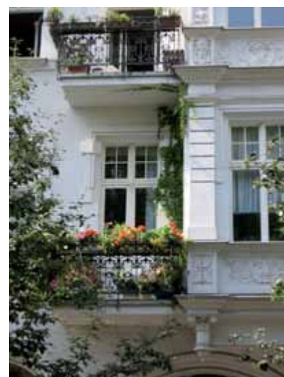
Zur Sanierung von Altbauten
